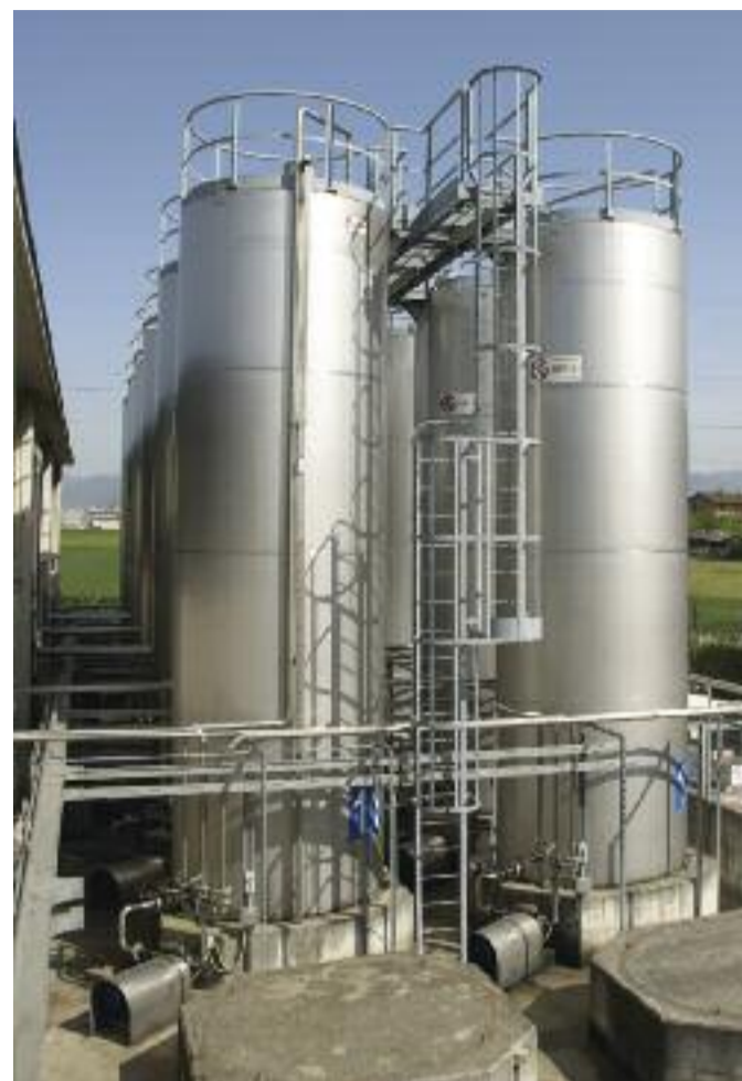
L'impianto di stoccaggio delle materie prime composto da 14 serbatoi con una capacità di 35.000 l ciascuno
